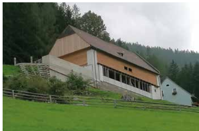
■ Der Jungviehstall wurde 2020 errichtet
